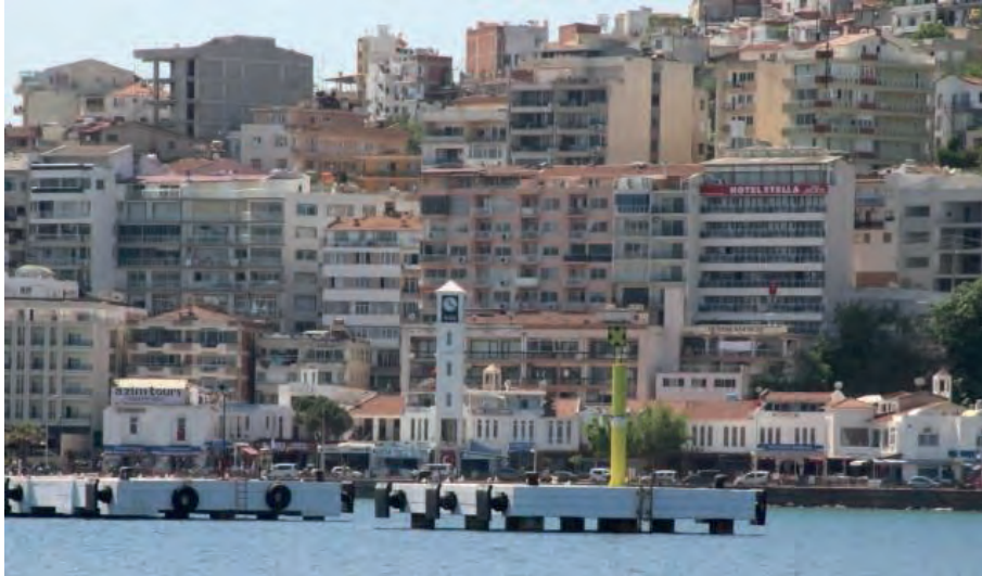
Şekil 3. Kent merkezindeki yüksek yoğunluklu yapılaşma (Bahattin Sürücü Arşivi, 2016)
