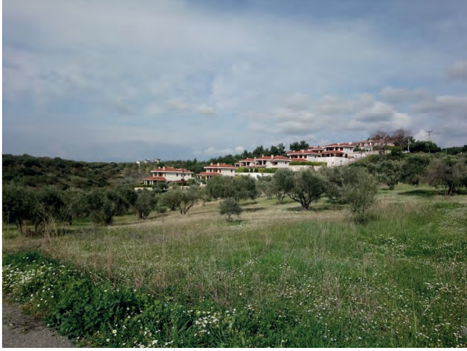
Şekil 9. Zeytinlikler arasında gelişme gösteren ikinci konut yapılaşmaları
